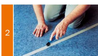
Corte la cinta adhesiva con la cuchilla de rueda, trapezoidal o dentada.
