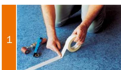
Coloque la cinta adhesiva especial de papel en el centro sobre la junta cerrada y presione con ayuda del rodillo de presión.
