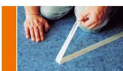
Transcurridos unos 10 minutos tras la realizar soldadura, retire la cinta adhesiva hacia atrás en sentido diagonal.
